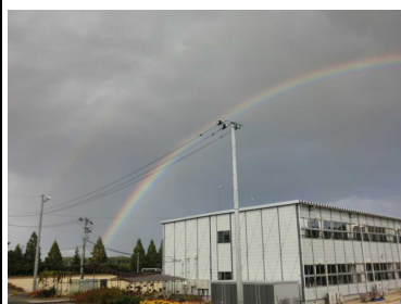
先日、仮設校舎に虹がきれいにかかりました。
